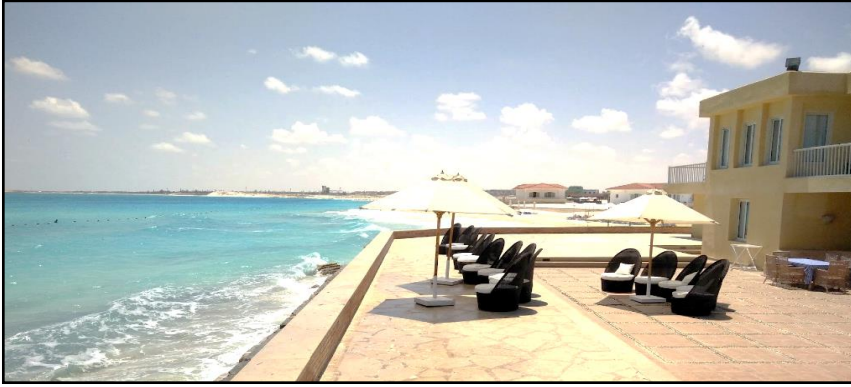
صورة رقم (7) البناء في حرم الشاطئ بقرية مراسي
